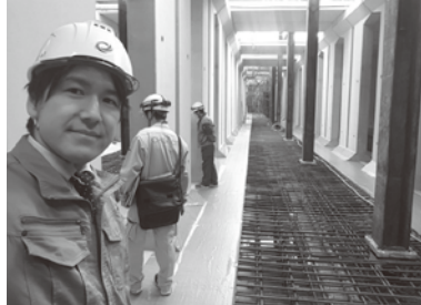
【宮崎・菰池公園の雨水貯留槽を視察】
