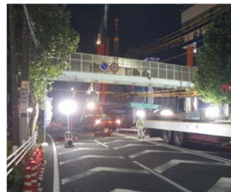
● 祐光歩道橋を撤去し、道路改善・交通安全対策を実現!
