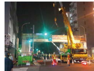
●院内歩道橋を撤去し、道路改善・交通安全対策を実現!
